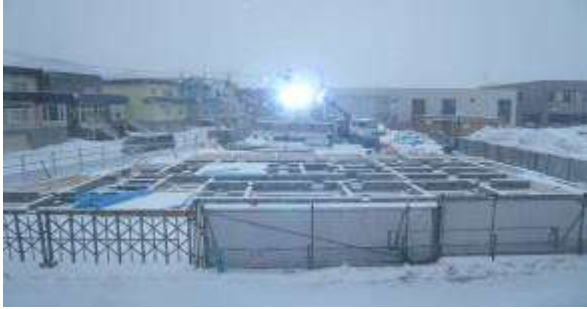
写真は建設中の様子(12月上旬頃)
